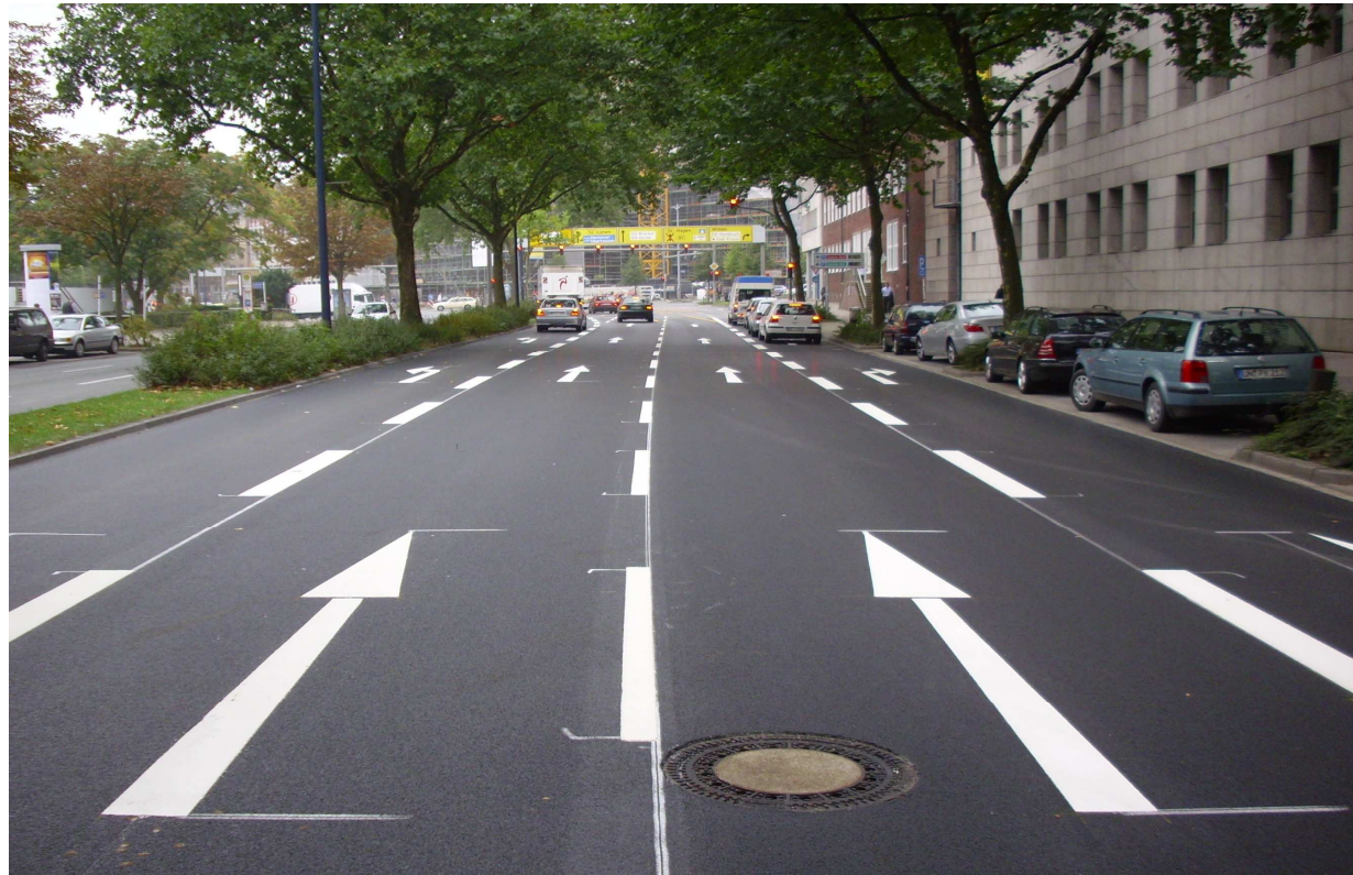
Hoher Wall / Hiltropwall - fertiggestellte Fahrbahn
