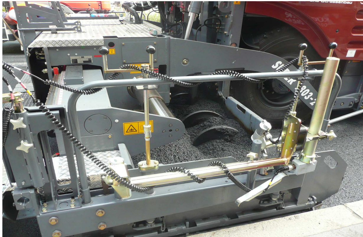
Hoher Wall / Hiltropwall – Einbau der Deckschicht
