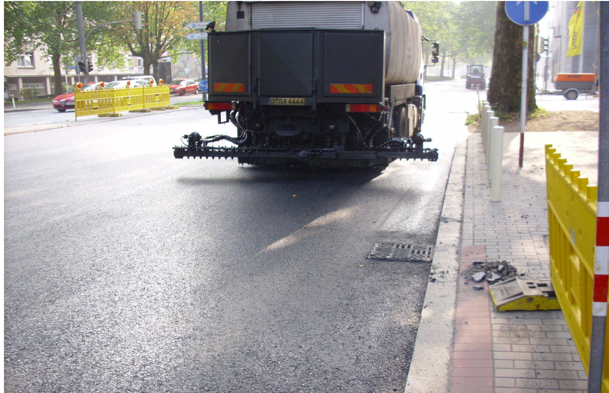
Hoher Wall / Hiltropwall – Anspritzen des Binders
