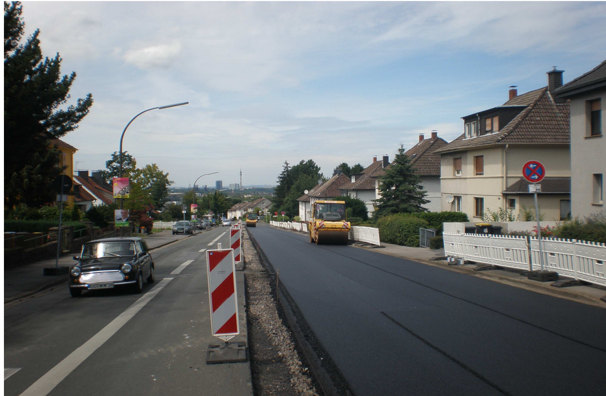
Benninghofer Straße - Verdichtung
