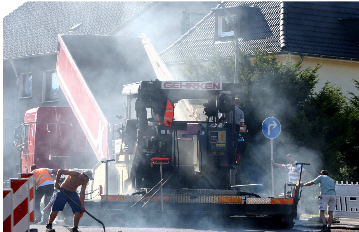
Benninghofer Straße – Einbau der Deckschicht
