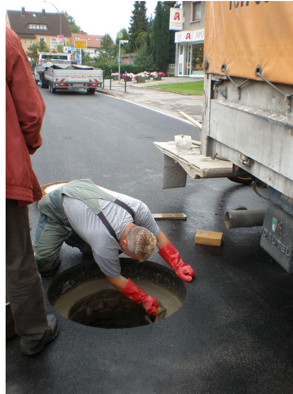
Benninghofer Straße – Einbau der Schachtabdeckungen
