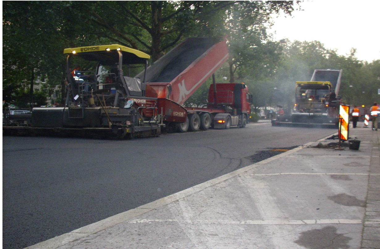
Hoher Wall / Hiltropwall – Einbau des Binders
