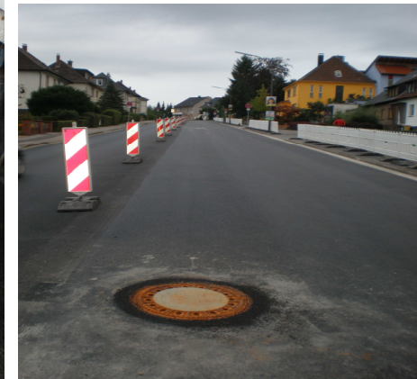
Benninghofer Straße – Einbau der Schachtabdeckungen
