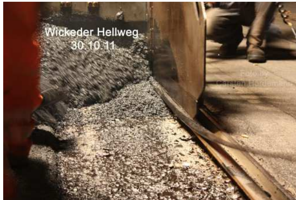
Wickeder Hellweg – Material fließt zwischen Gleis und Beton
