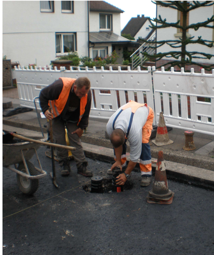
Benninghofer Straße / Wittbräucker Straße – Einbau der Schieberkappen
