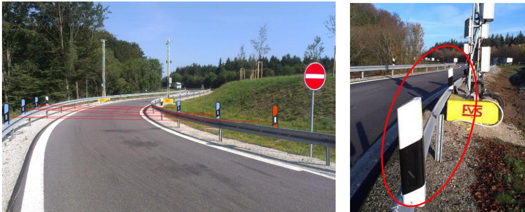
Abbildung 21: Links: schematischer Aufbau des Systems „Einfahrt“; rechts: in die Leitpfosten integriertes System „Einfahrt“ mit Mast zur Kontrollfunktion (parkplatzeigene Ausstattung)
