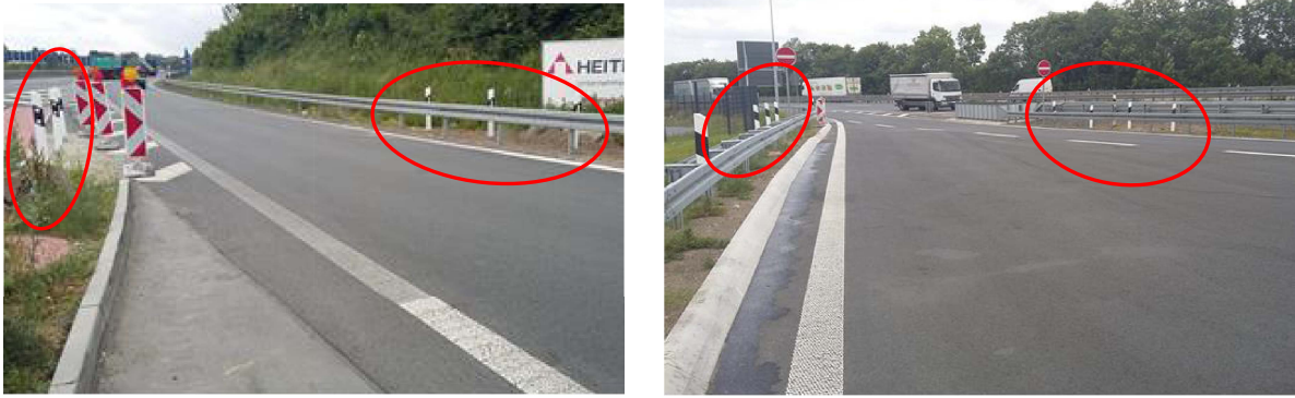
Abbildung 31: Aufbau des Systems an Ein- und Ausfahrt der Tank- und Rastanlage
