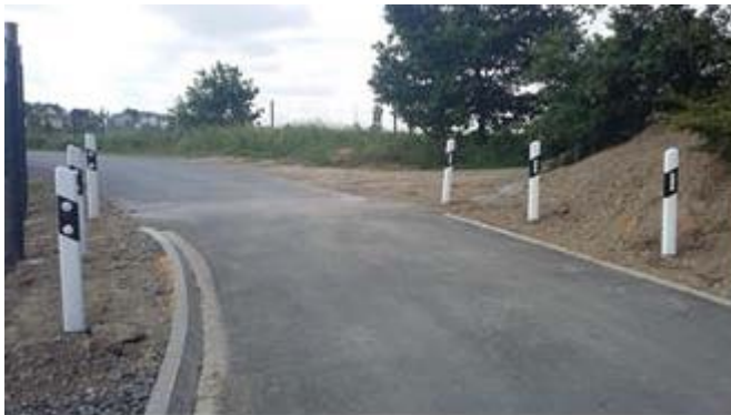
Abbildung 32: Ausstattung des Versorgungswegs
