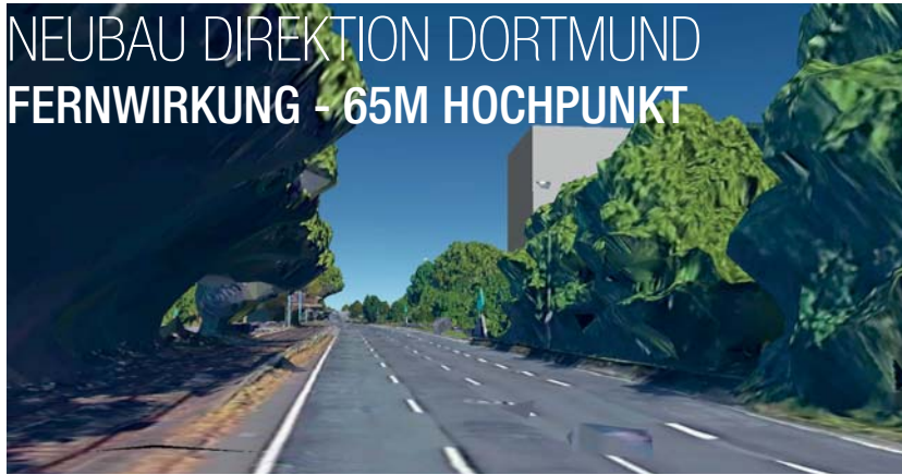
Westfalendamm - Blick von Westen
