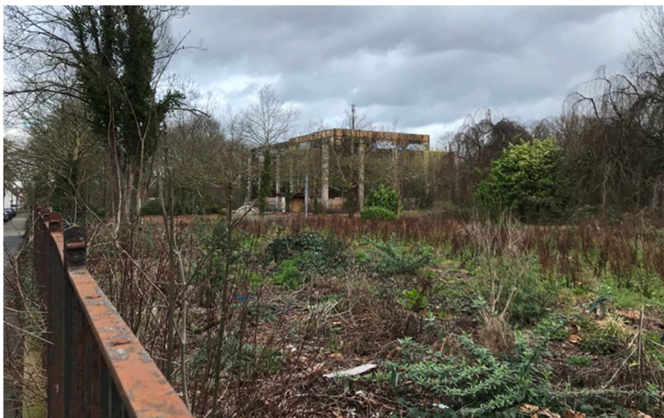
Abbildung Plangebiet Max-Eyth-Straße 2 mit Bestandsgebäude (Quelle: Instone Real Development GmbH)
