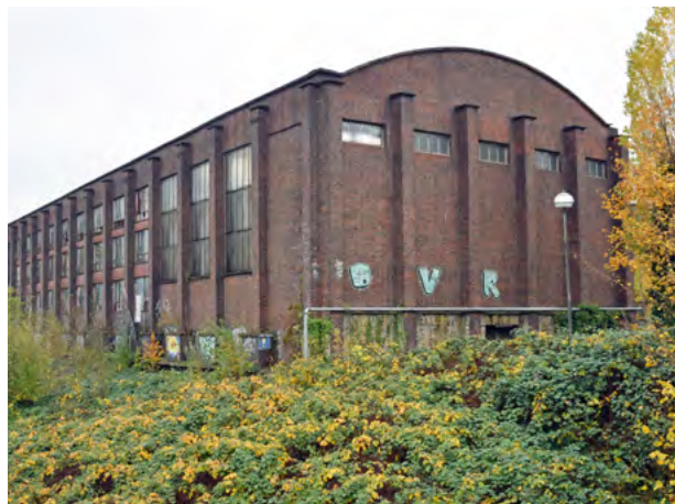
Abbildung 41: Feldherrnhalle, Ansicht von Süden
