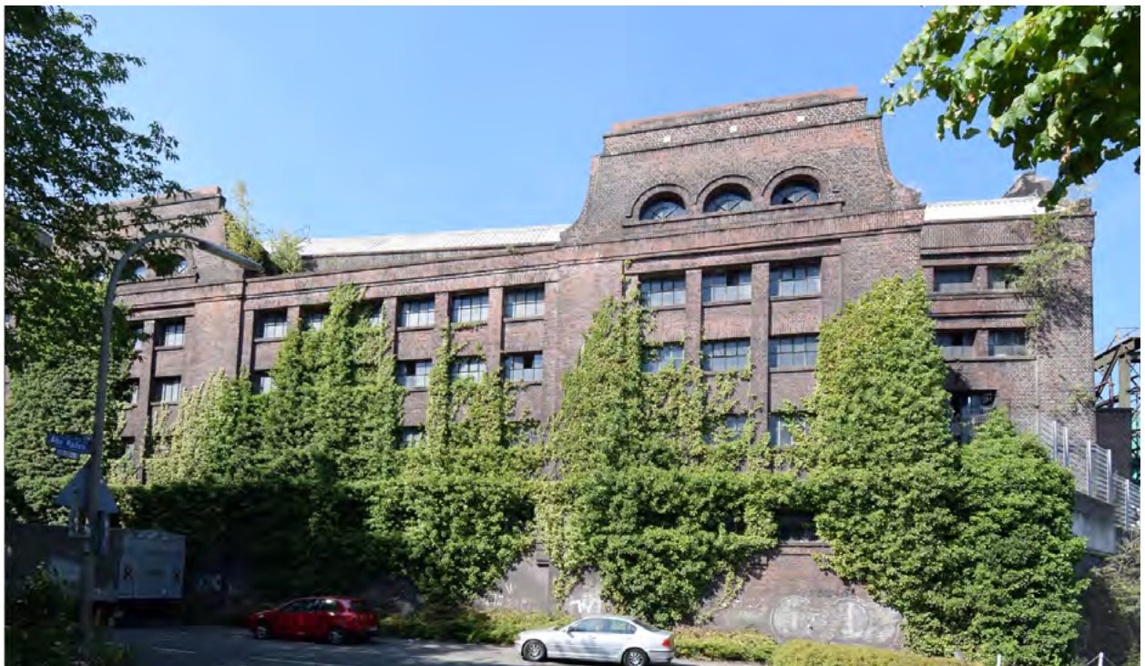
Abbildung 39: Walzendreherei, Ansicht von Osten
