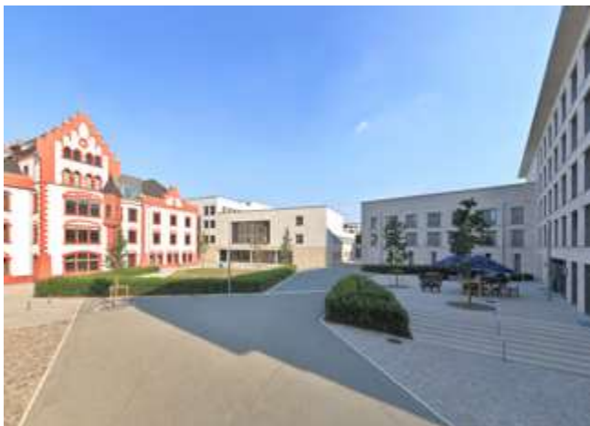
Blick in den Hof der umgebauten Hörder Burg mit Neubau und Hotel, 2016.
