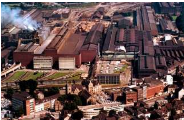
Der städtebauliche Kontext der historischen Hörder Burg um 1970. In der Bildmitte das Stahlwerk, dessen Gebäudebestand an der Stelle des heutigen Phoenix-Sees vollständig abgerissen worden ist.
